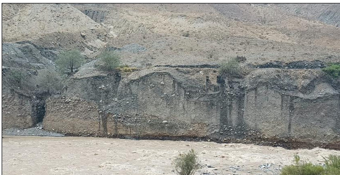
FIGURA N°02: CARRETERA HUAYANAY EXPUESTA ANTE UNA CRECIDA DEL RÍO PISCO EN LA MARGEN DERECHA
